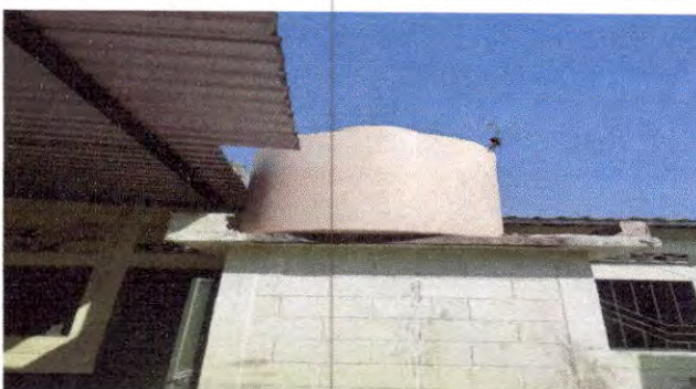
Foto 10: Reparación y mantenimiento de cisternas/ depósitos de agua: Sustitución de depósito de agua.
