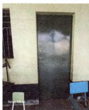
Foto 2: Puertas de metal: Mantenimiento a estructura (lijado, cambio de tubo, cepillado, sujeciones, aplicación de pintura) en módulo 1 y 2 de aulas.
