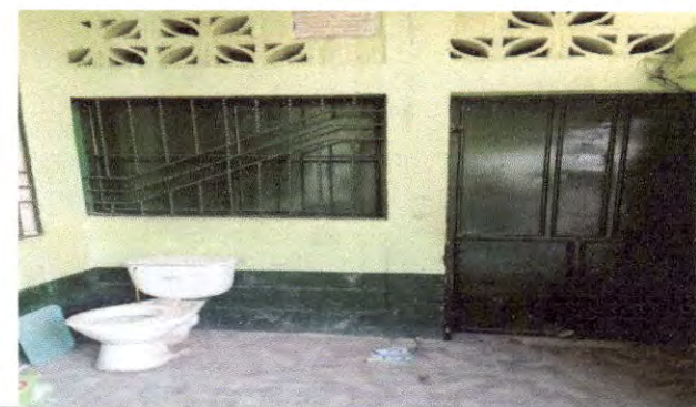
Foto 3: Ventanas: mantenimiento a balcones y ventanas de metal en módulos 1 y 2 en aulas.
