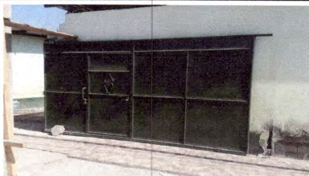
Foto 8: Puertas: Mantenimiento de portones de metal en entrada principal.
