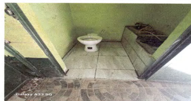
Foto 5: piso: Sustitución de piso cerámico por piso cerámico en módulo 1 en baños.
