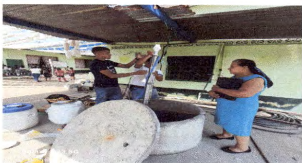
Foto 11: Reparación y mantenimiento de cisternas depósitos de agua: sustitución de bomba de agua.
