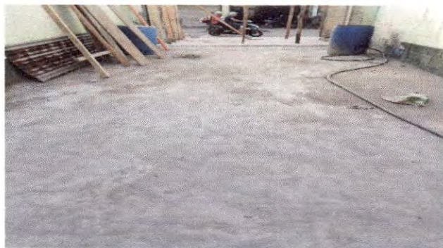
Foto 9: Piso: Reparación de plancha de concreto de entrada principal.
