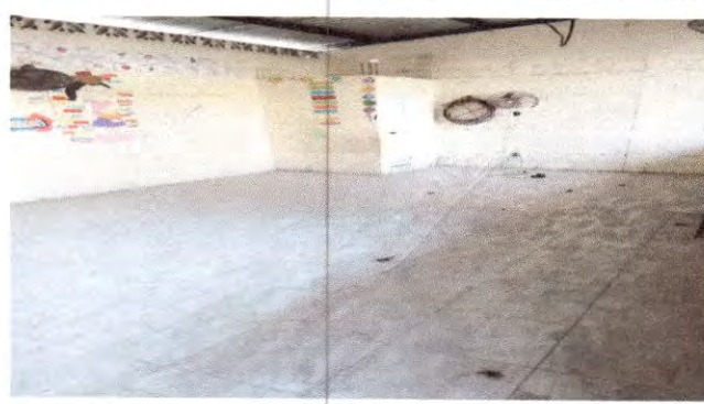
Foto 4: Piso: Sustitución de piso de cemento líquido por piso cerámico en módulo 1 en aulas.
