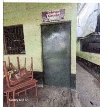
Foto 2: Puertas de metal: Mantenimiento a estructura (lijado, cambio de tubo, cepillado, sujeciones, aplicación de pintura) en módulo 1 y 2 de aulas.
