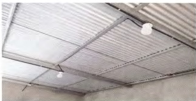
Foto 15: Reparación del sistema eléctrico: Instalación unidades de luz módulo 1 de aulas, cocina y salón.
